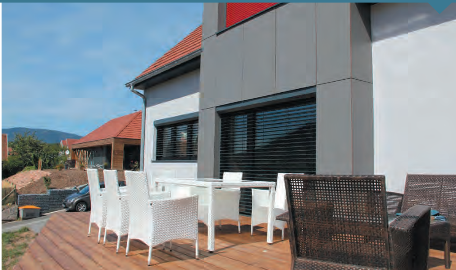
La terrasse montée sur Technopieux.
