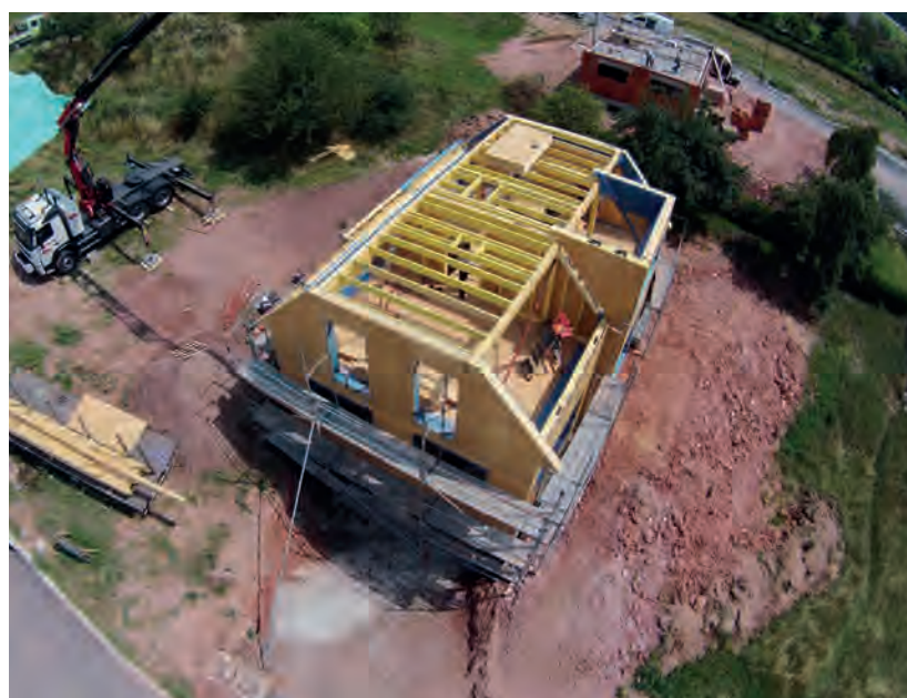
Vue aérienne du chantier.
